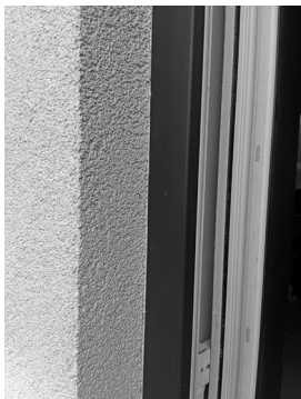
Рис. 2. Трещина на стыке оконной рамы и откоса
