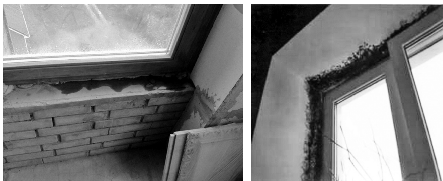
Рис. 6. Появление замоканий и плесени на откосах окна
